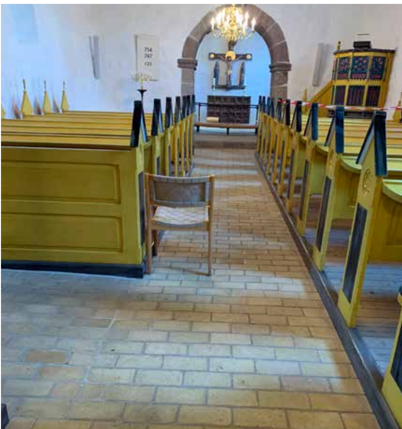
Forskellige billeder af knækket på midtergangen – også set oppe fra pulpituret. Stolen står der for at give et indtryk af størrelsesforholdene.
